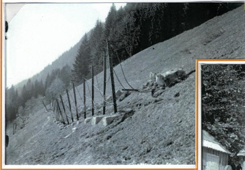
*Im Frühjahr: ein beschädigter Arlbergrechen hoch über dem Verlauf der Arlbergbahn (volare.at)*
